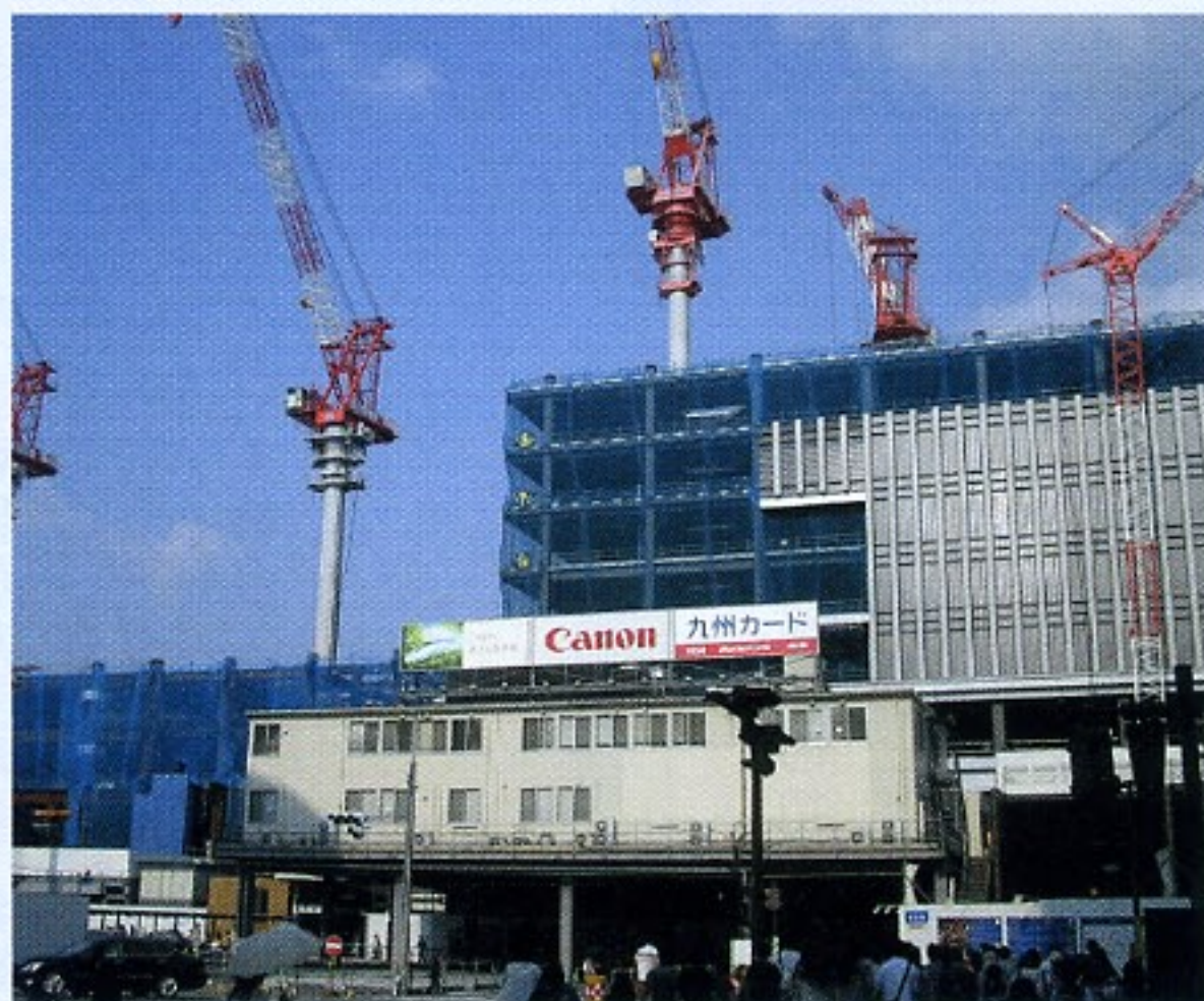
新駅ビル開業へ向けて工事のピッチが上がる博多駅
