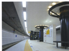
九条駅ホーム階(写真3)
