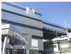
西九条駅延伸部(写真1)
