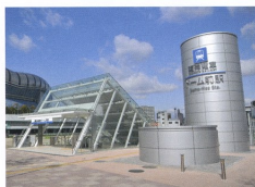
ドーム前駅南側出入口(写真4)
