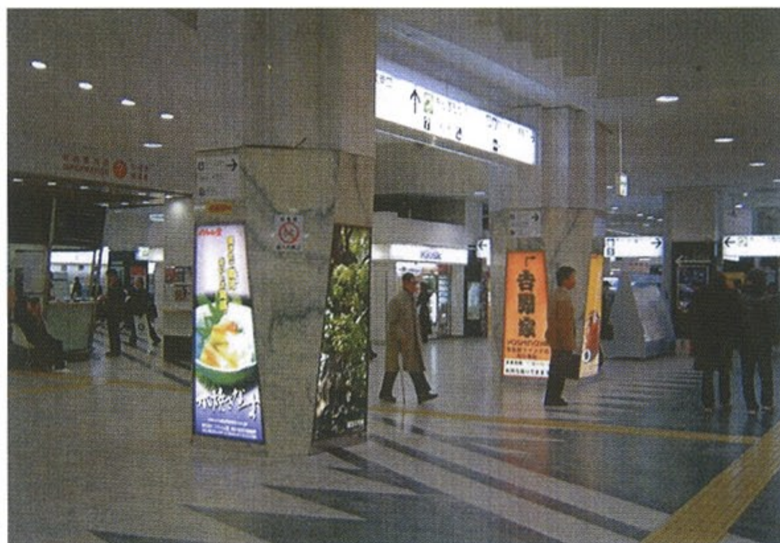
コンコース総合案内所付近（工事支障前）
