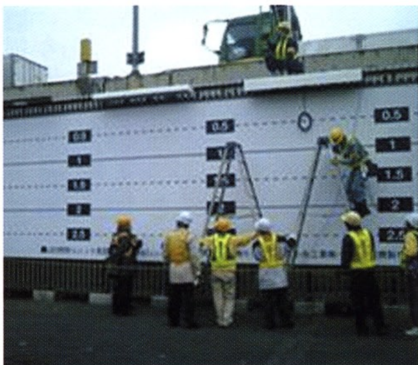
実証実験(千駄ヶ谷駅)
