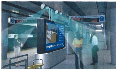
地下の鉄道駅ホーム上に設置された音声付超大型映像ネットワークメディア「Metro Mega Wide Vision(メトロメガワイドビジョン)」1号機。
