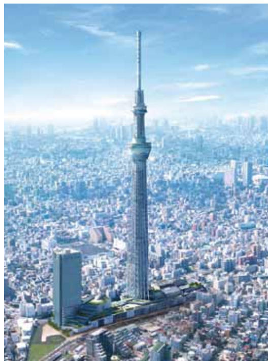
「東京スカイツリータウン®」全景
