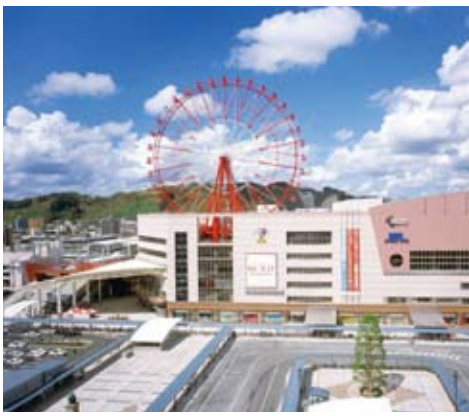
駅ビルアミュプラザ鹿児島
